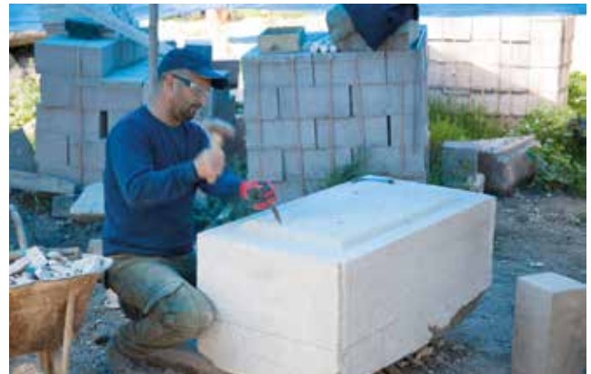
Fotoğraf 6. Taş ustalığı eğitim programında, Kızıl Avlu'daki destek payandasının kaidesi için çırak tarafından hazırlanan kesme taş, 2019 (Pergamon Kazı Arşivi) / Ashlar block cut and dressed by the apprentice for the foundation of buttress in the Red Hall, in the framework of the stonemason training program, 2019 (Pergamon Excavation Archive).
