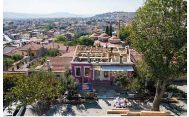
Fotoğraf 11. Ağustos 2021’de yangın geçiren evlerin proje kapsamında yenilenen çatıları, Ekim 2021 (Pergamon Kazı Arşivi) / Reconstructing roofs of historic houses affected by the fire in August 2021, October 2021 (Pergamon Excavation Archive).
