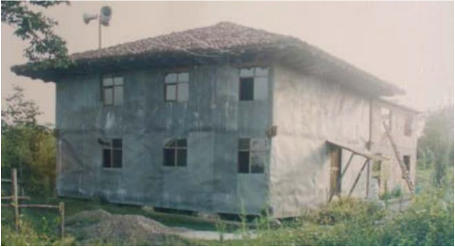
Fot. 2. Porsuk Camii kuzey ve doğu cephe görüntüleri (Bayraktar, 2013, 359.).
