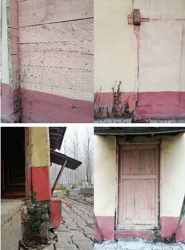
Fot. 20. Porsuk Camii cephelerinde bitki oluşumu.
