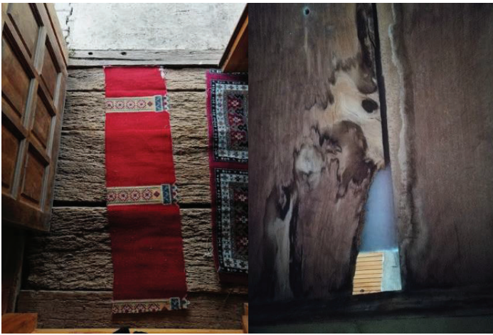
Fot. 18. Porsuk Camii'nde bulunan aşınmalar ve parça kopmaları.
