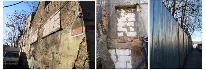
Şekil 16. Kasımpaşa Un Fabrikası'nın Kapatılmış Yüzeyleri
