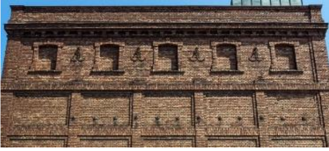
Şekil 10. Eski Ambar Binasının Cephesi (Pichler, 2017)
