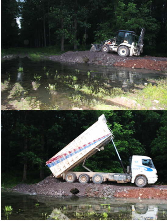
Şekil 6. Üretim sahasında drenaj çalışmaları (2020) Figure 6. Drainage working at the harvesting site (2020)
