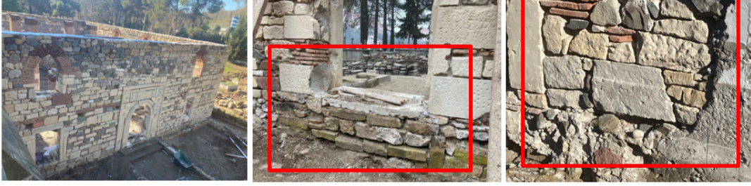
Görsel -9 a-b-c: Kuzey cephe, kapı ve pencere zeminine yapılan dolgular
