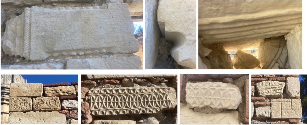
Görsel-11 a-b-c-d-e-f-g: Beden duvarlarında devşirme malzeme kullanımı
