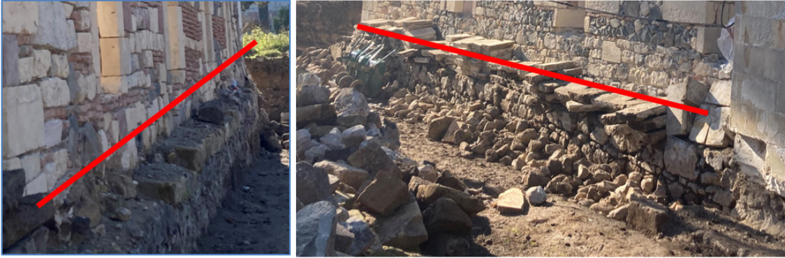
Görsel-8 a-b: Birinci dönem yapısına ait temel duvarları
