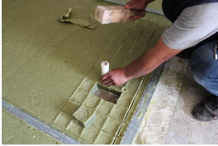
Kaynak: M. Çiftyürek
