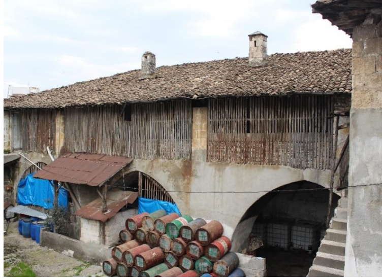
Şekil 4: Kuseyri Sabunhanesi'nin Avluya Bakan Batı Cephesi
