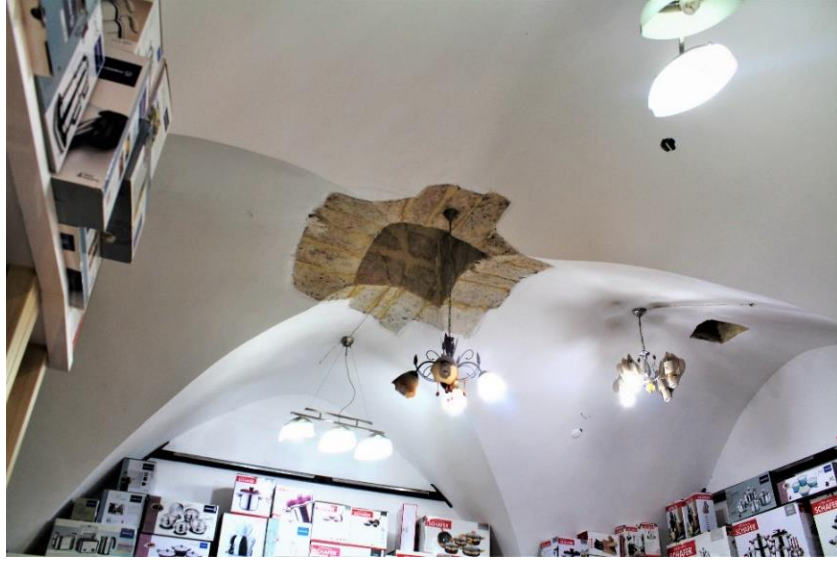
Şekil 15: Haytoğlu Sabunhanesi Çapraz Tonozdaki Kare Boşluk
