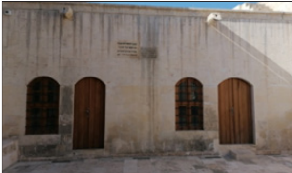
Ek 12. Kilis Sinagogu, Restorasyon Sonrası, Batı Cephesi Genel Görünüm
