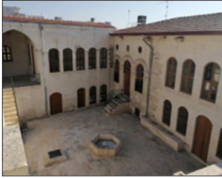
Ek 8. Kilis Sinagogu, Restorasyon Sonrası Avlu, Doğu ve Güney Cephesi
