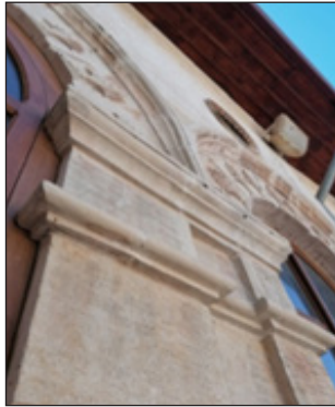
Ek 18. Kilis Sinagogu, Restorasyon Sonrası, Güney Cephedeki Kemer Binmeleri ve Silmeler
