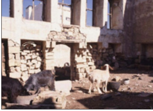
Ek 5. Kilis Sinagogu, Restorasyon Öncesi Doğu Cephesi ( https://www.omnia.ie/ )
