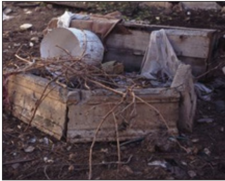
Ek 9. Kilis Sinagogu, Restorasyon Öncesi Avludaki Havuz ( https://www.omnia.ie/ )
