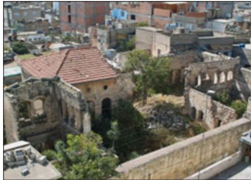
Ek 3. Kilis Sinagogu, Restorasyon Öncesi Genel Görünüm ( https://www.omnia.ie/ )
