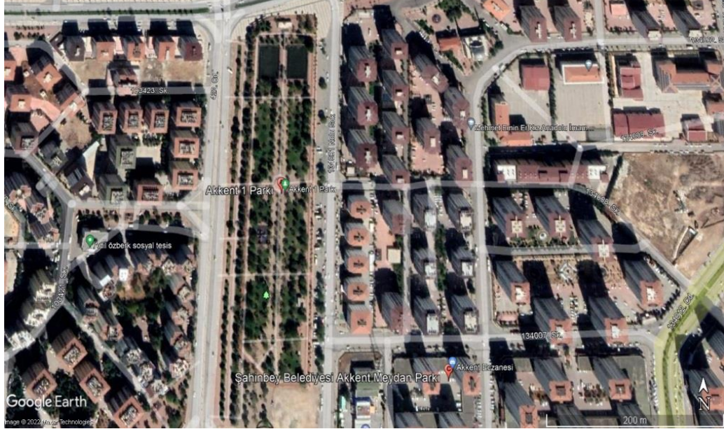
Fotoğraf 3. Akkent Parkına Ait Uydu Görüntüsü (Google Earth, https://earth.google.com/ adresinden 15.03.2022 tarihinde erişilmiştir.).
