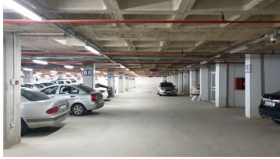
Şekil 6: Kapalı otoparkın yağmurlama sistemi
