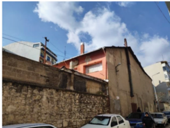
Şekil 4 Gençlik Sinemasının Yan Cephesi (Azsöz, 2022)
