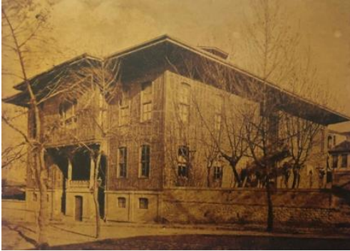
Şekil 11. Sergi Dairesi İttihaz Edilen Bursa Daire-i Belediyesi
