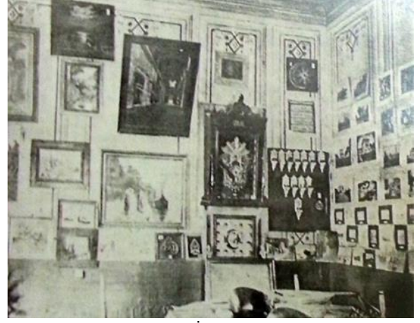
Şekil 13. Sergi Dairesi İttihaz Edilen Bursa Daire-i Belediyesi
