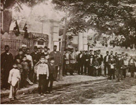
Şekil 15. Sergi Dairesi İttihaz Edilen Bursa Daire-i Belediyesi
