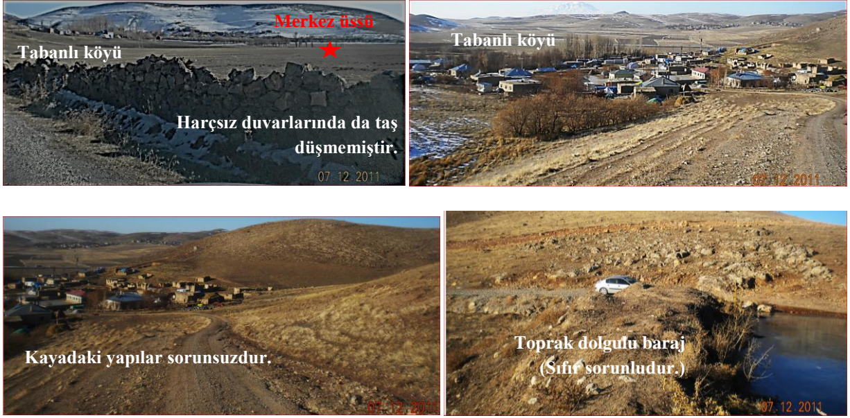
Şekil 4. Ovanın çamurundan kurtulmak için evlerini yamaç eteği ve yamacı kuran Tabanlı köylüleri depremi can kaybı ve yaralanma olmadan atlarken harçsız taş duvarları (a,b,c) ve toprak dolgu barajları da (d) sorunsuzdur. Figure 4. The villagers of Tabanlı, who built their houses on the slopes to get rid of the mud of the plain, survived the earthquake without loss of life or injury, while the stone walls (a,b,c) and earthfill dams without mortar (d) are also without problems.
