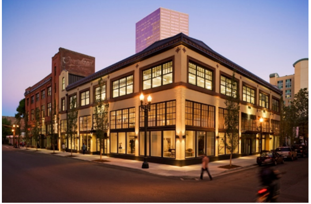
Şekil 7. Desoto binası genel görünümü (URL-10, 2022)
