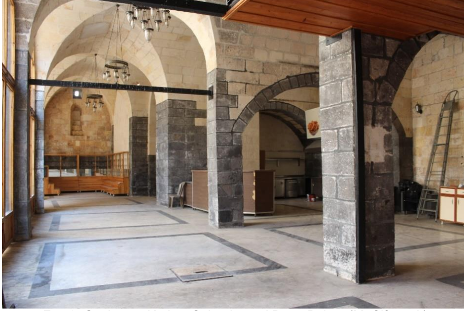
Fot. 3: Gaziantep Kürkçü Sabunhanesi Doğu Bölüm (M. Çiftyürek)
