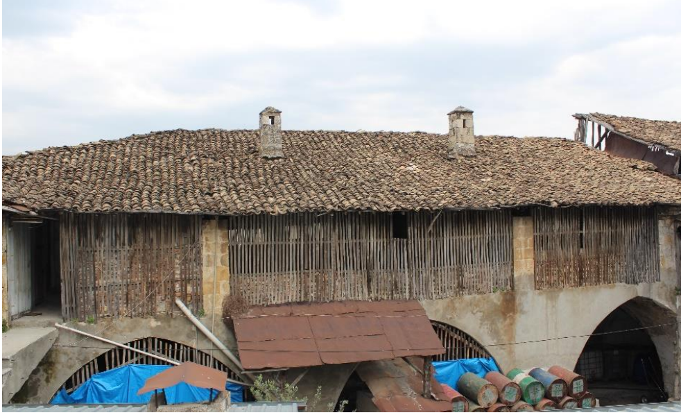
Fot. 26: Antakya Kuseyri Sabunhanesi Ahşap Perdeler (M. Çiftyürek)
