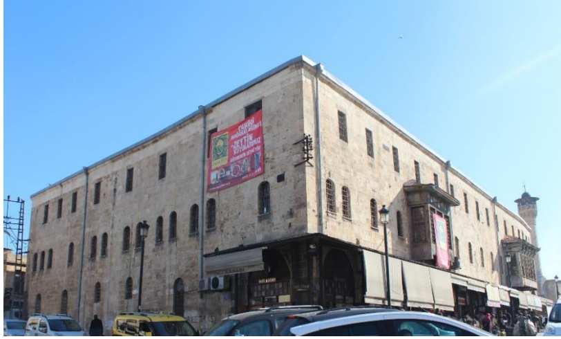
Fot. 13: Gaziantep Elbeyli Sabunhanesi Batı ve Kuzey Cephe (M. Çiftyürek)
