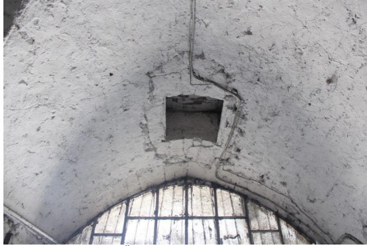
Fot. 23: Antakya Hasan Ökten Sabunhanesi Kare Boşluk (M. Çiftiyürek)
