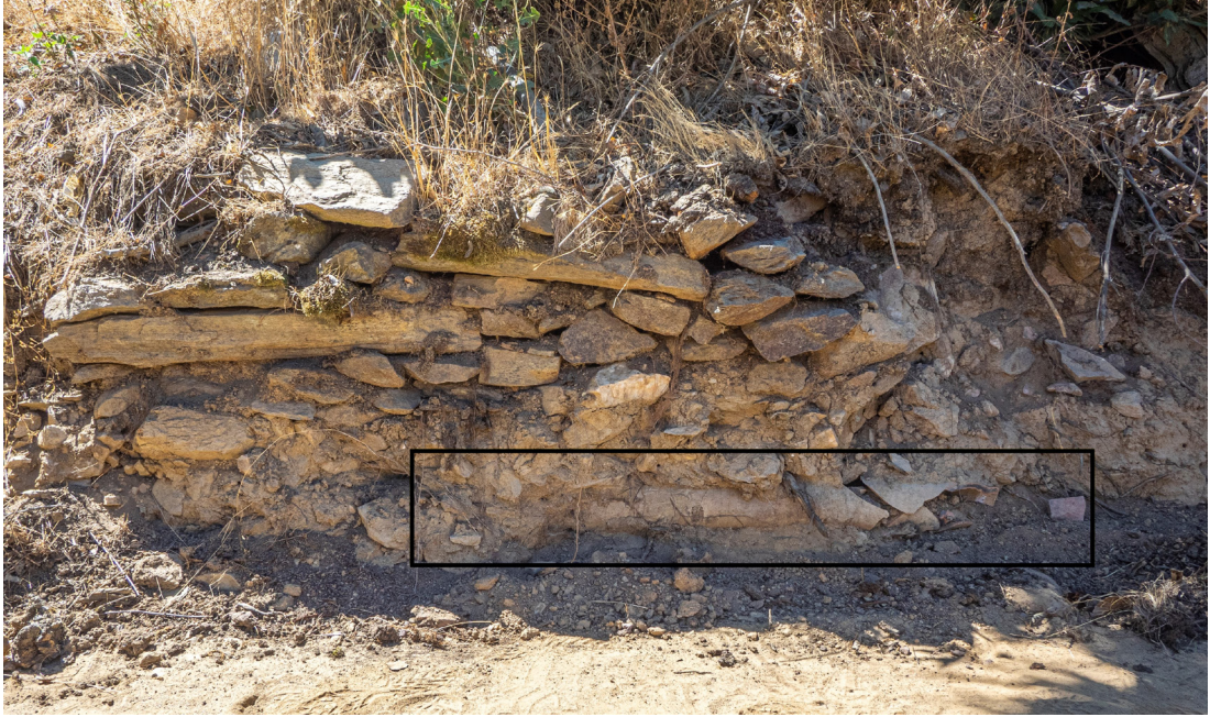
Fig.9. Duvar altında uzanan su künkleri
