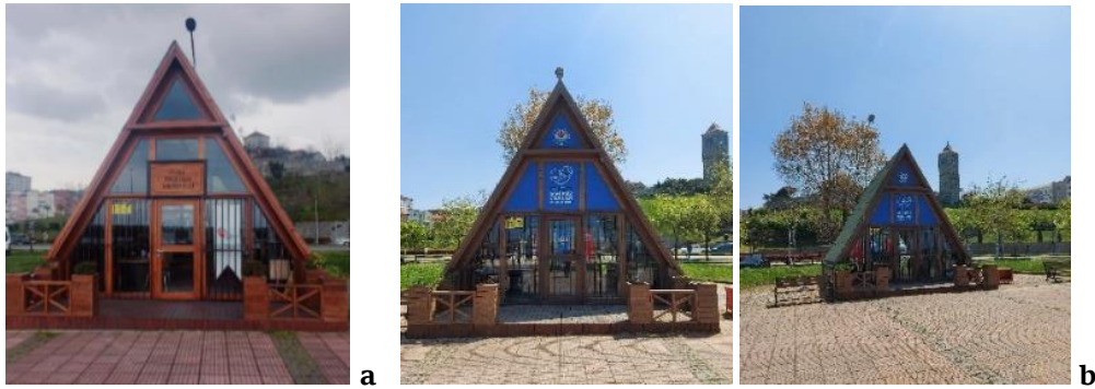
Şekil 22. (a) Yaşlı Destek Merkezi 44 , (b) Sokak Hayvanları Bakım Merkezi (Z. Yanılmaz Arşivi)
