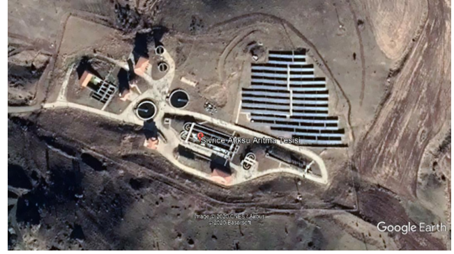
Şekil 16. Atık Su Arıtma Tesisi (URL 3)
