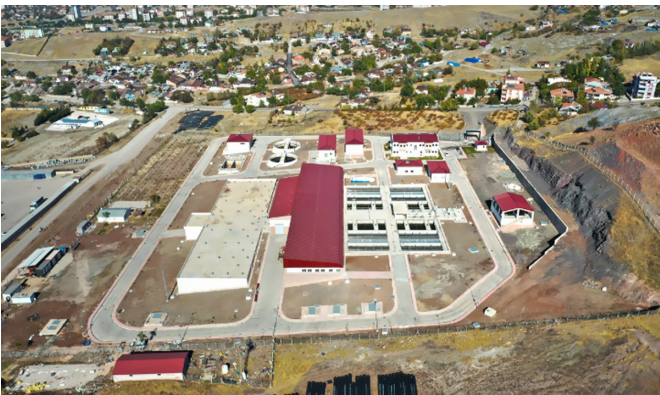
Şekil 15. Karşıyaka Mahallesinde bulunan İçme Suyu Arıtma Tesisi (Elazığ Belediyesi, 2022b)
