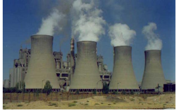
Fotoğraf 2. Afşin-Elbistan A termik santrali. Photo 2. A Thermal power plant of Afşin-Elbistan.
