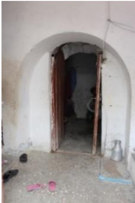
Fot. 39: Muhdes Yapı İçinde Kalmış Bulunan Çeşme Nişi
