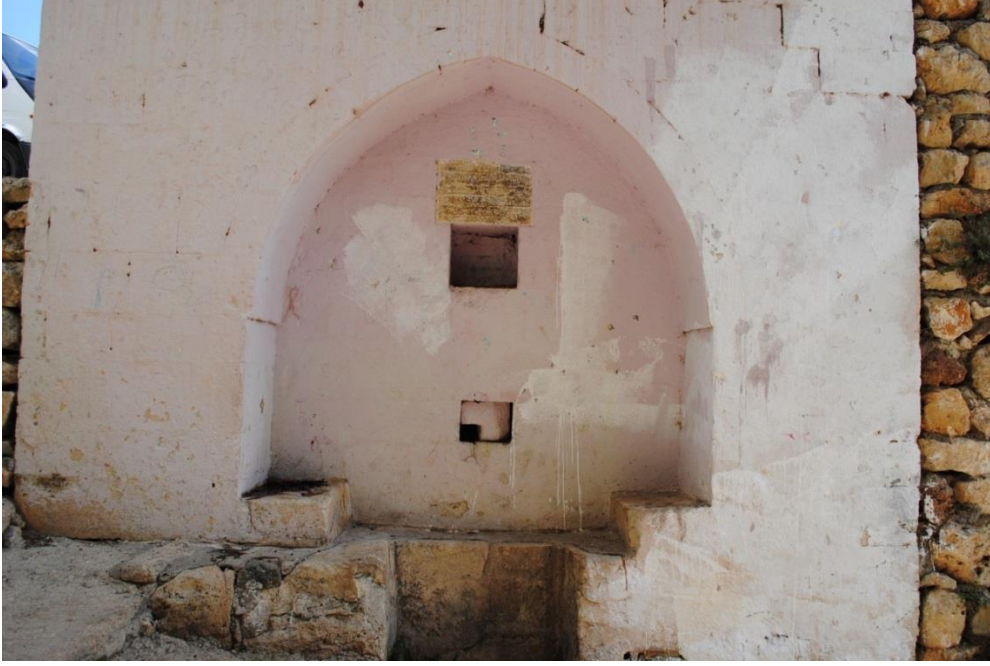
Fot. 16: Dağdüzü Mahalle Çeşmesi 1- Batı Cephesi
