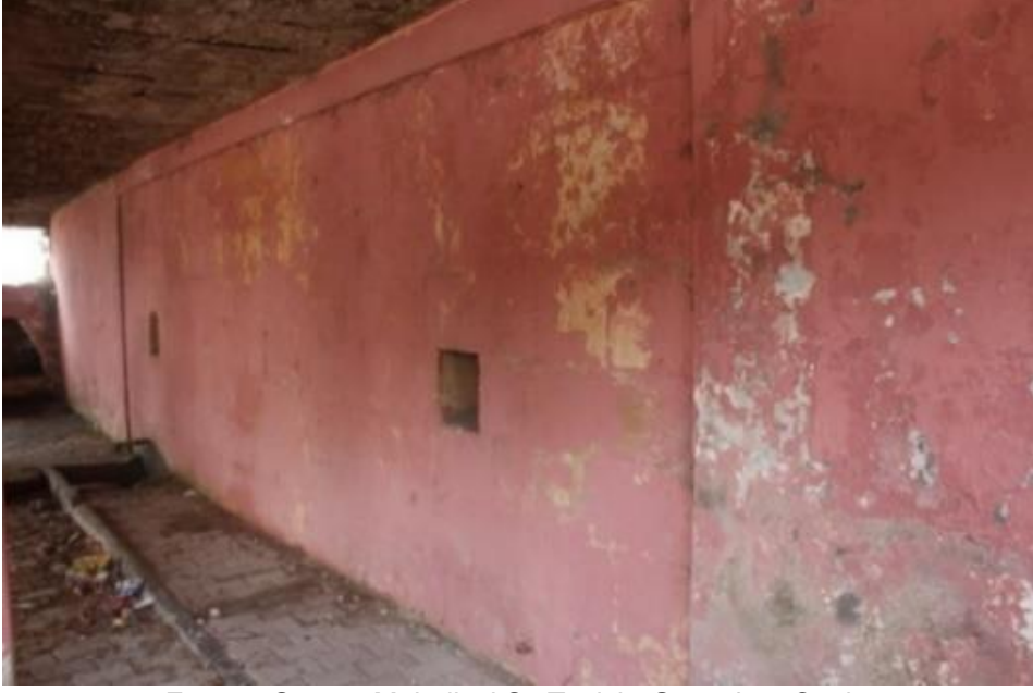
Fot. 36: Sungur Mahallesi Su Tesisi - Güneybatı Cephe
