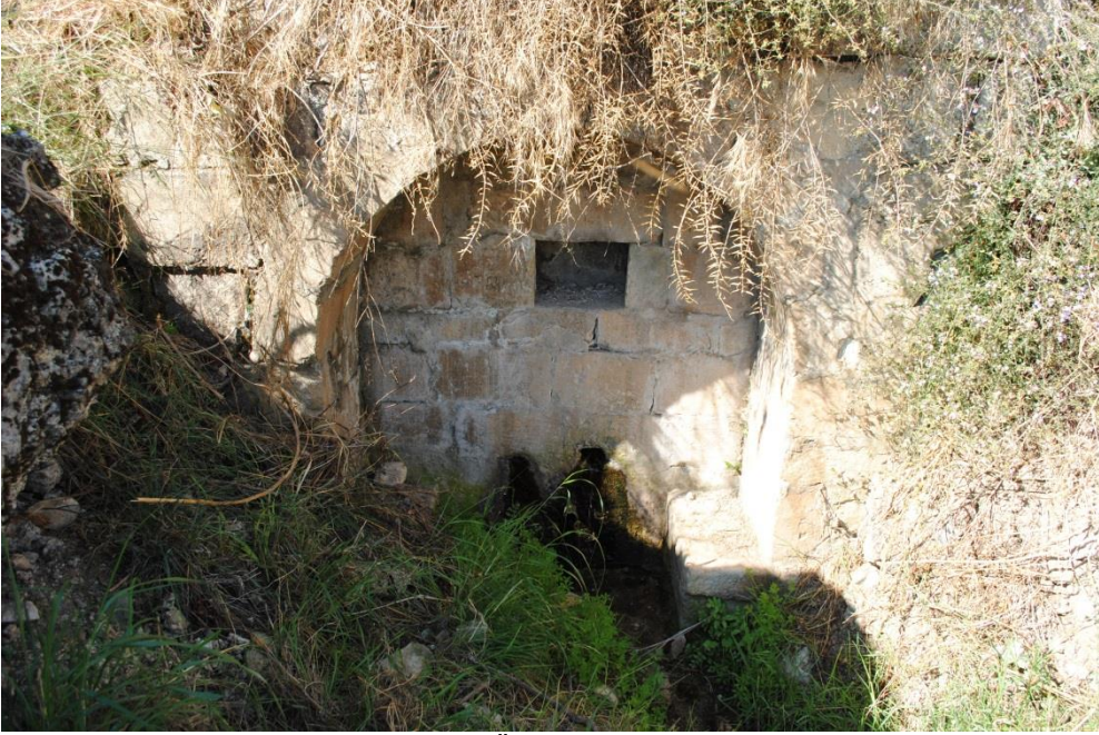
Fot. 1: Hatice Öksüz Hayratı Cephesi
