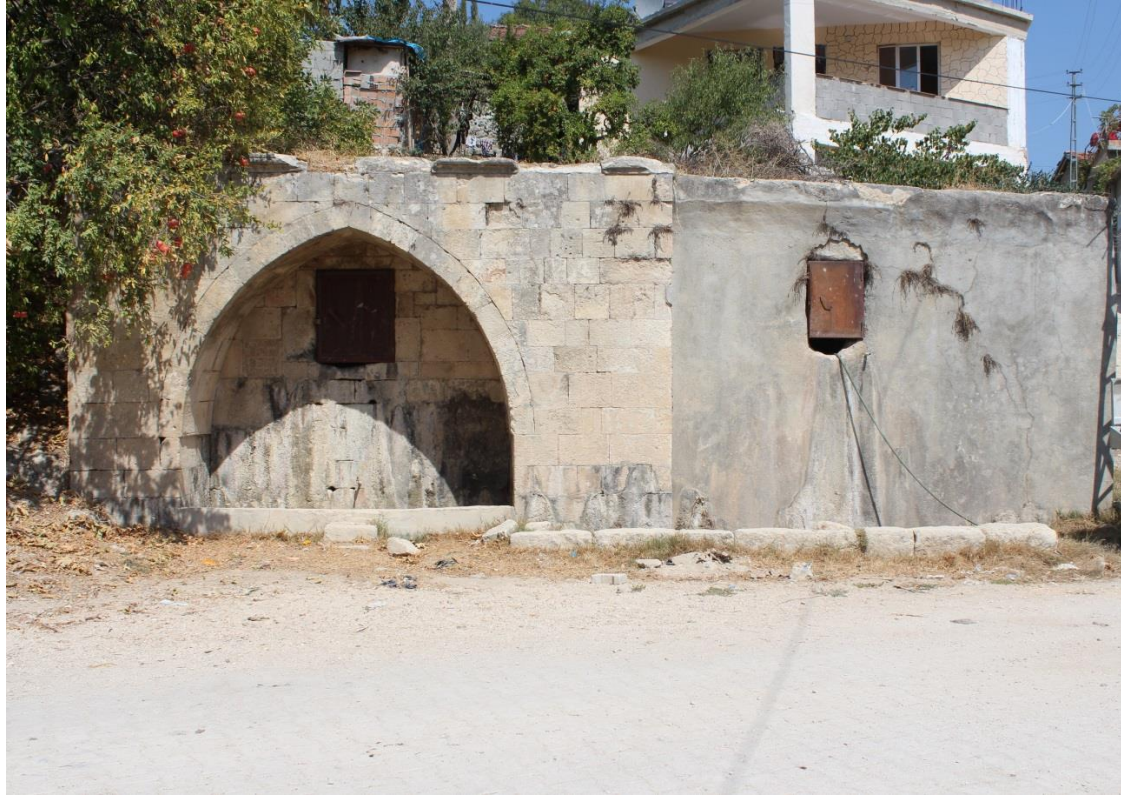
Fot. 45 Yunushanı Mahalle eşmesi Güney Cephe
