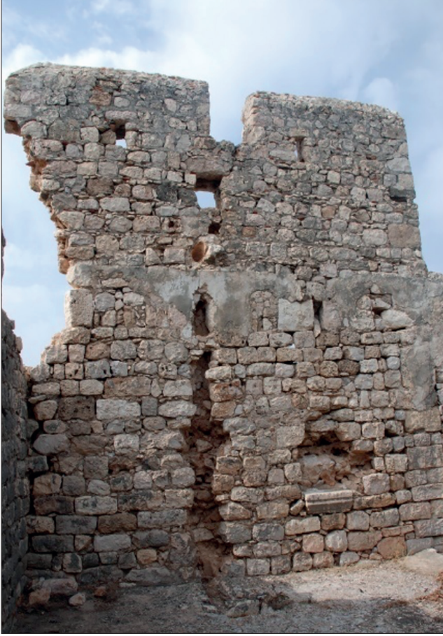
Fotoğraf 34. Batı iç duvarında su hattı ve zeminde sarniç deliği / The waterline in the west wall and the cistern entrance hole in the floor. (E.S. Cesur, 2009)
