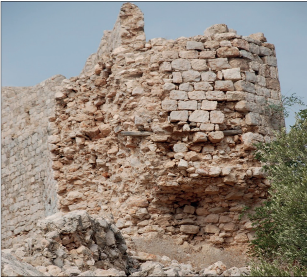
Fotoğraf 16. E burcu, güney görünüşü / Bastion E, south view (E.S. Cesur, 2009)
