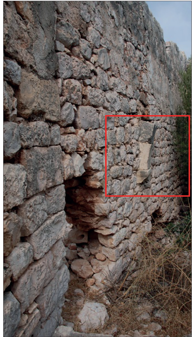
Fotoğraf 33. Kemer hattı ve üzengi taşı / Arch line and stirrup stone . (E.S. Cesur, 2009)
