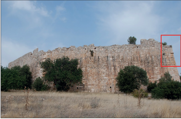
Fotoğraf 8. Güneybatı dış duvarı / Southwestern outer wall . (E.S. Cesur, 2009)
