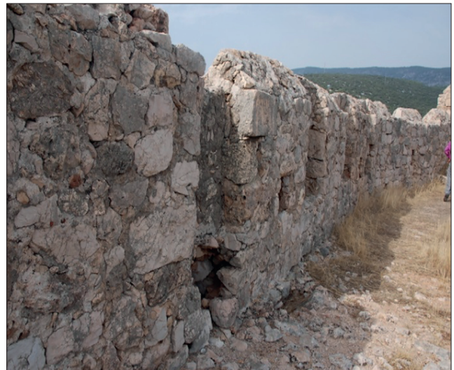
Fotoğraf 22. Batı, doldurulan dendanlar / West wall, filled dendants. (E.S. Cesur, 2009)
