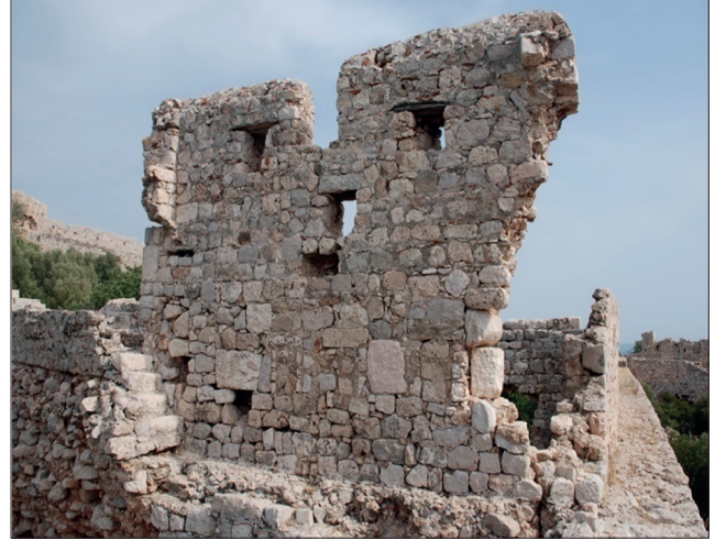
Fotoğraf 36. C yapısı batı duvarı dış görünüşü / Exterior view of the west wall of structure C. (E.S. Cesur, 2009)
