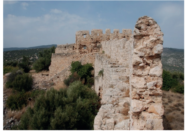
Fotoğraf 19. D-E burcu arasındaki duvar / Wall between D and E bastions (E.S. Cesur, 2009)
