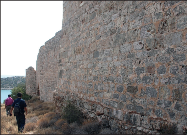
Fotoğraf 24. Kuzeydoğuda, D burcunda duvar örgüsü ve derzler / Masonry and joints in Northeast, bastion D. (E.S. Cesur, 2009)
