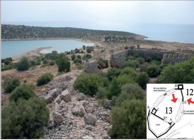
Fotoğraf 13. Yok olan doğu duvarı / Collapsed east wall (E.S. Cesur, 2009)
