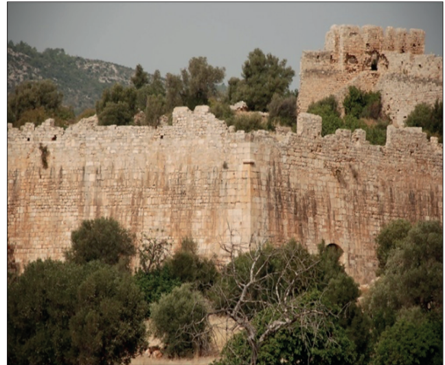
Fotoğraf 3. Güney köşesi (dış) detay / South corner (external) detail. (E.S. Cesur, 2009)
