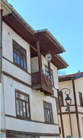
GörSEL 20. Balkon üstü payandası alınlıksız olan yapı örneği
