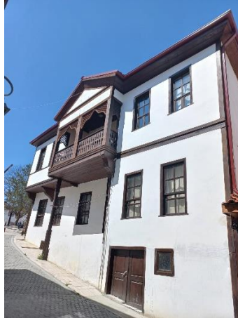
Görsel 10. Balkonun kapı üstünde konumlanmaması örneği
