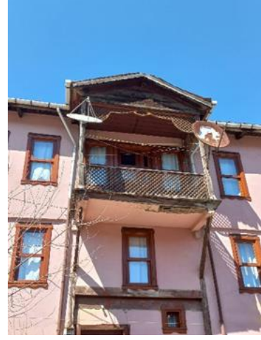
GörSEL 21. Balkon üstü payandası alınlıkla bütünleşmiş yapı örneği
