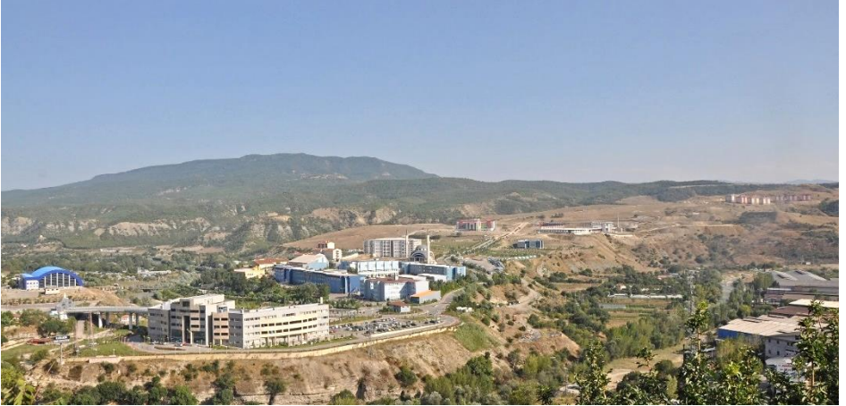
Foto 5. Karabük Üniversitesi Demir Çelik Yerleşkesi'nin 2013 Eylül Ayındaki Görünümü. (Fotoğraf, Mimarlık Fakültesi Fakülte Sekreteri Hayati Demir'den Alınmıştır.)
