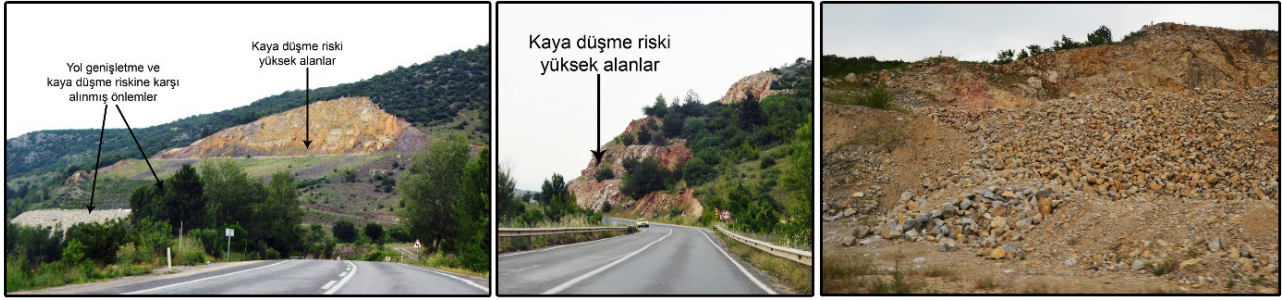
Fotoğraf 3- Hamzabey-Çayırılı arasındaki (D-595 karayolu) kaya düşme tehlikesi yüksek alanlar Photo 3- Areas with high rockfall risk between Hamzabey and Çayırılı (D595 highway)
