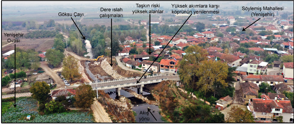
Fotoğraf 5- Göksu Çayı üzerinde (Söylemiş) sel-taşkın tehlikesine karşı köprülerin yenilenmesi ve dere ıslah çalışmaları (Yenişehir belediye arşivi)
