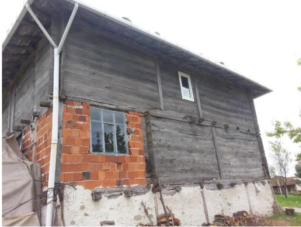
Resim 10: Alagömlük Köyü Rahmioğlu Mahallesi Camii'nin Batı Cephesi.
