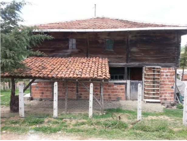
Resim 8: Alagömlük Köyü Rahmioğlu Mahallesi Camii'nin Doğu Cephesi.
