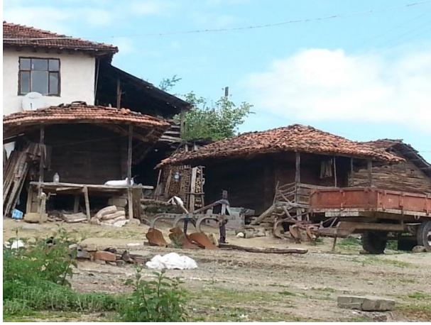
Resim 13: Alağömlük Köyü'ndeki Çanti Tekniğinde İnşa Edilmiş Ambarlar.
