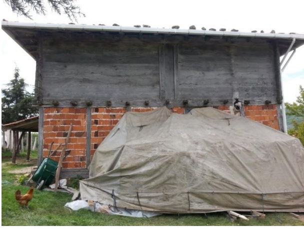
Resim 9: Alagömlük Köyü Rahmioğlu Mahallesi Camii'nin Kuzey Cephesi.
