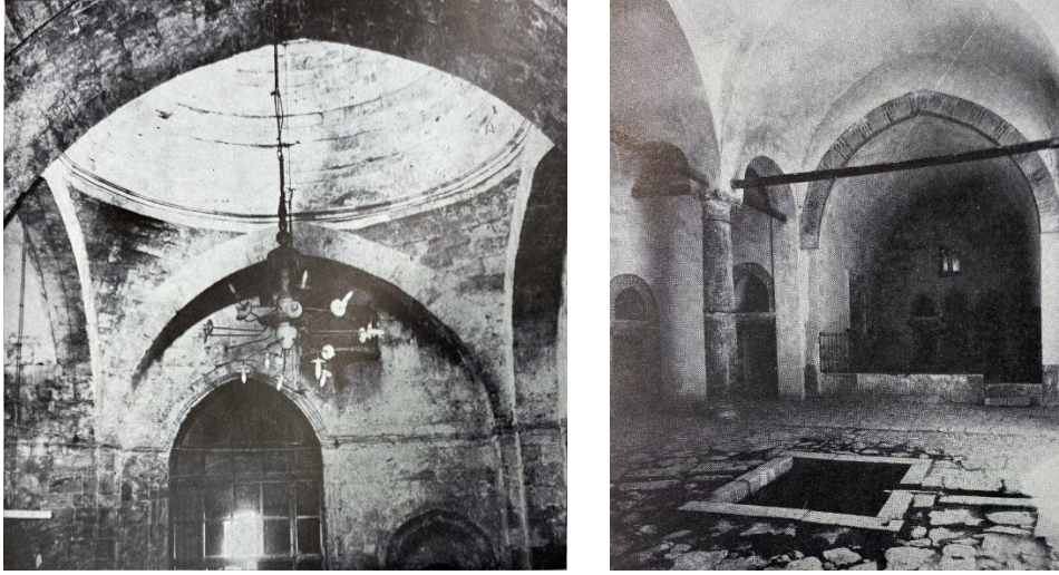
Şekil 8: Medrese avlusunda kubbenin tepesinden gelen açıklık ile iç mekanın aydınlatılması (Kuran, 1969, görsel bölümü içinde).
