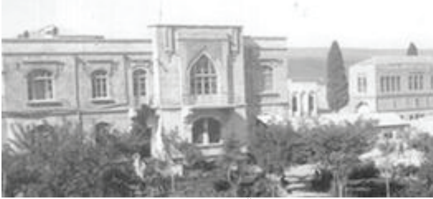
Foto. 14: Belediye Binası Öne Taşkın Portal
