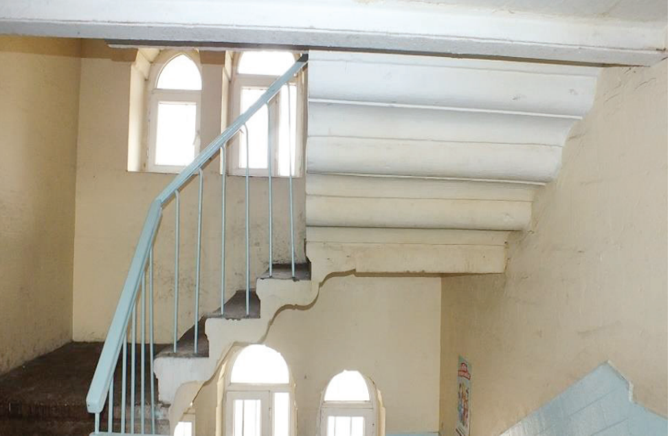
Foto. 11: Basmahane, Ara Kat Uygulaması
