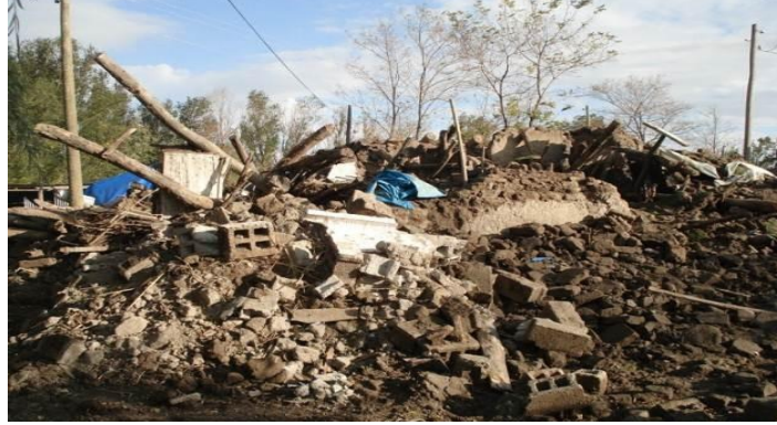
Şekil 69. Van Gölü Köyü 2011 Depreminde Yıkılan Bir Yiğma Yapı Enkazı
