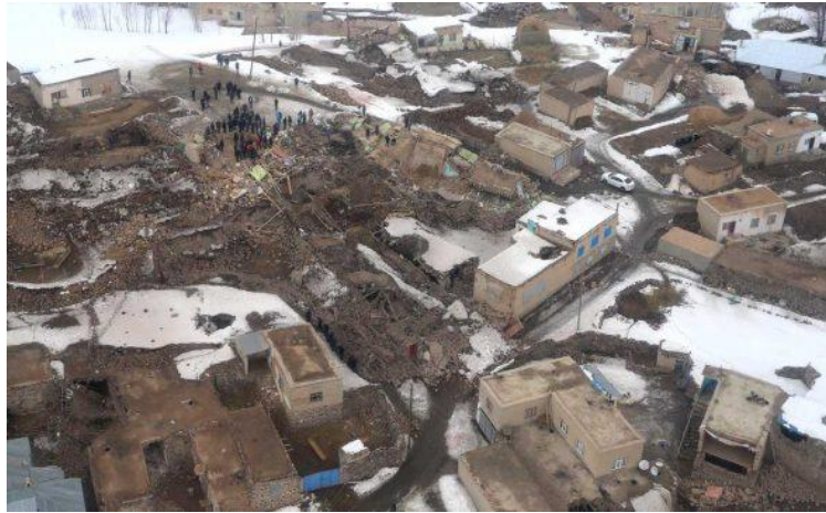
Şekil 73. Deprem Görmüş Bir Köyde Yığma Yapı Hasarı (Van-Başkale 2021)
