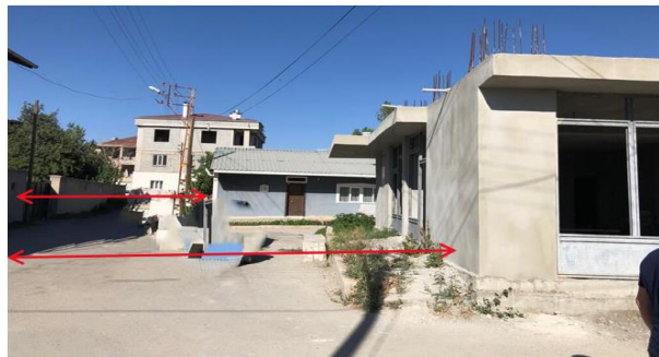
Şekil 28. Yoldan Yetersiz ve Farklı Oranda Çekme Mesafeli Yapı Örnekleri, Van Eminpaşa Mahallesi,2022 Yılı
