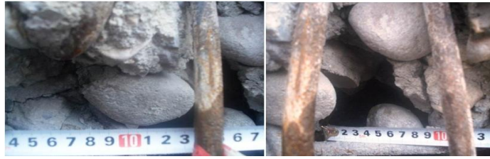
Şekil 52,53. Betonda Granülometriye Uymayan Agreganın Oluşturduğu Boşluk (URL-9)
