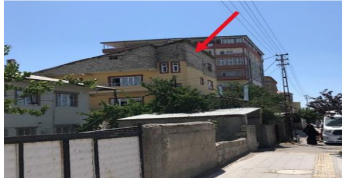
Şekil 47. Kalkan Duvar Kullanımı, Van Selimbey Mahallesi
