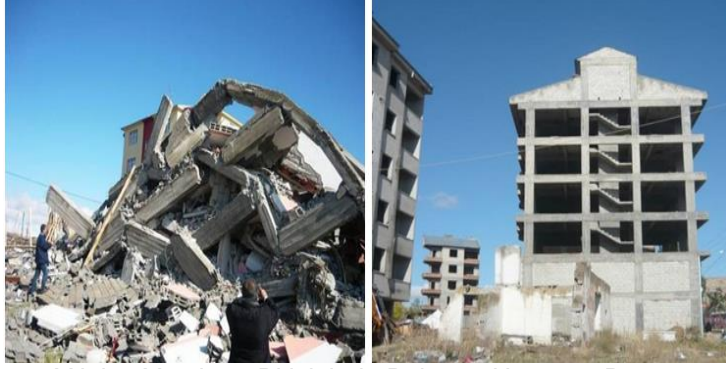
Şekil 74,75. Yıkılan Yapıların Bitişinde Bulunan Hasarsız Betonarme Yapılar
