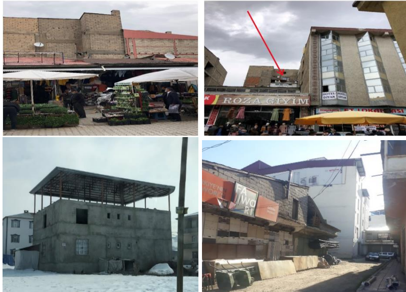
Şekil 37-40. Van Kent Merkezinde Eksik ve Riskli Yapı Örnekleri
