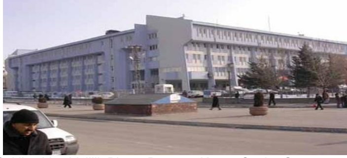
Şekil 5. Van Valilik Binası Doğu ve Kuzey Cephe Görünümü
