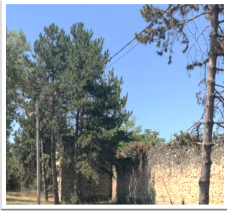
Resim 10. Ali Hıfzî Paşa Konağı Sur Duvarları
