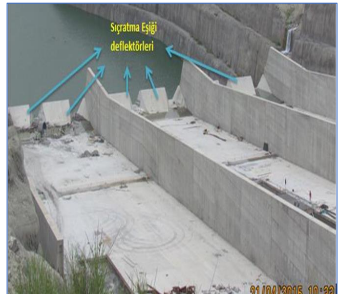
Şekil 5. Dişli Sıçratma Eşiği (Slotted Bucket)
