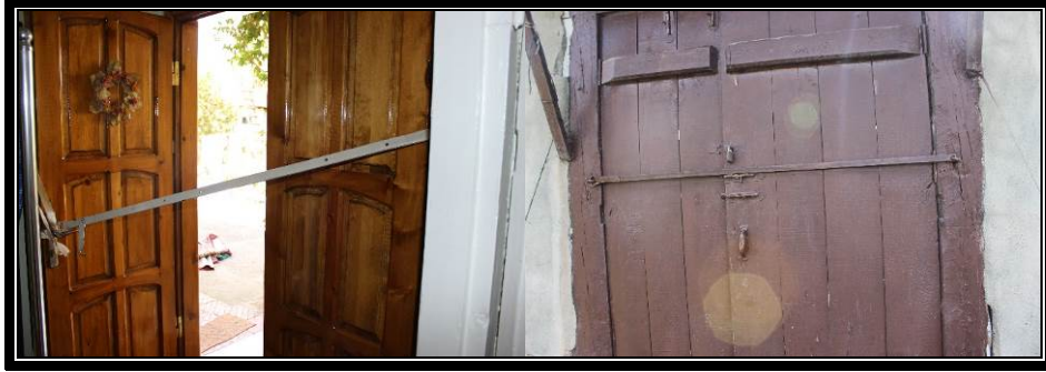
Fotoğraf 8. Bahçe ve giriş kapılarında uygulanan çelik koruyucu sistemi.
