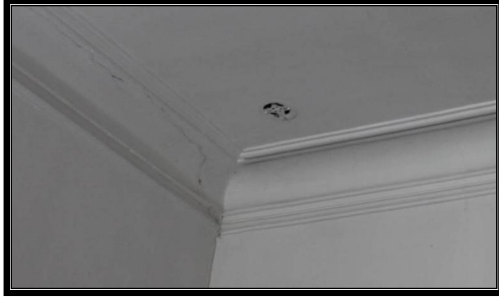
Fotoğraf 12. Ali Ataman Konağı'nda havalandırma sistemi.
