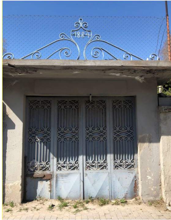
Şekil 17. Gaziler Caddesi (Eski Kervan Köprüsü Yolu) üzerinde bulunan özgün giriş kapısı ve üzerinde dövme demir 1884 tarihi (Fotoğraf: Şener, 2019)
