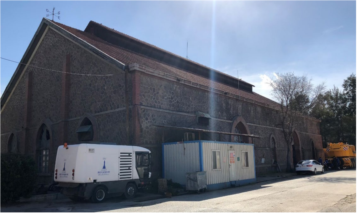
Şekil 9. Kuzey ve doğu cephesi (Fotoğraf: Şener, 2019)
