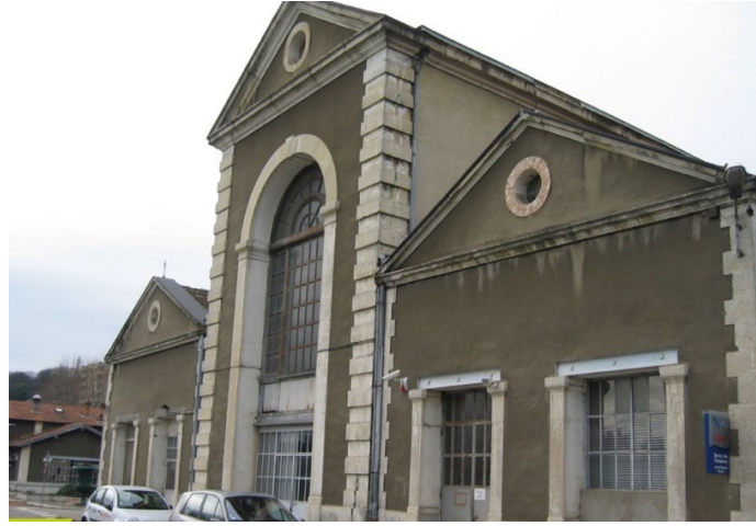
Şekil 22. Saint-Clair Su Pompa İstasyonu (Lyon Su Müzesi) (URL 2)
