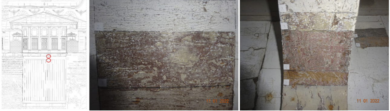
Şekil 6 III. Osman Köşkü'nün Gülhane cephesi, araştırma noktaları 11-13, yakın çekim (Güryapı Arşivi)
