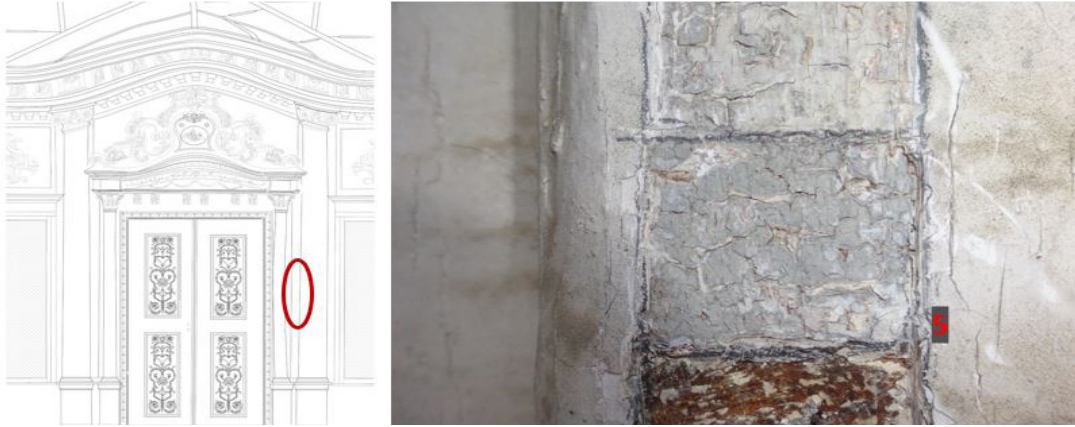
Şekil 9 III. Osman Köşkü'nün taşlık cephesi, Nokta 2, yakın çekim (Güryapı Arşivi)
