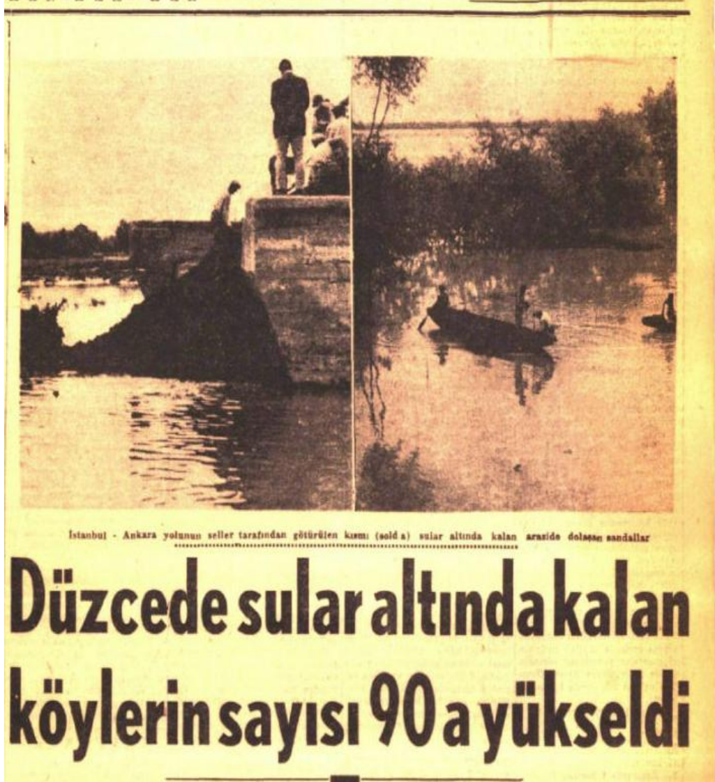
Ek-2: İstanbul-Ankara Yolunun Seller Tarafından Götürülen Kısmı (Solda) Sular Altında Kalan Arazide Dolaşan Sandallar (Sağda)
