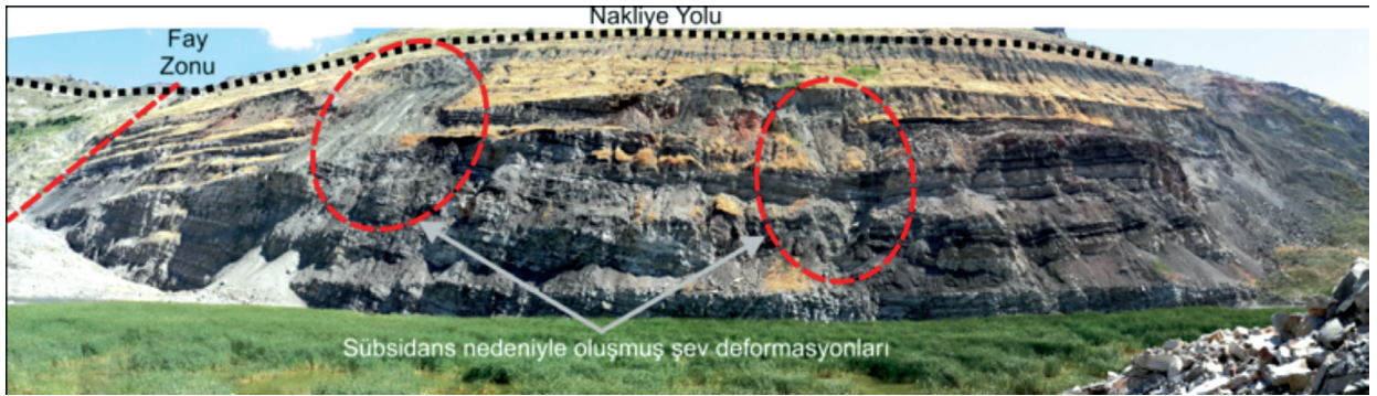
Şekil 6. M_3 biriminin üst seviyelerinde gözlenen KM_3 kömür damarı ve P_1 -formasyonu arasındaki uyumlu dokanak ve elek yolunun kuzeyinde yer alan yüksek açılı yamaçlarda yer altı üretimi sonrasında meydana gelen şev deformasyonları.
