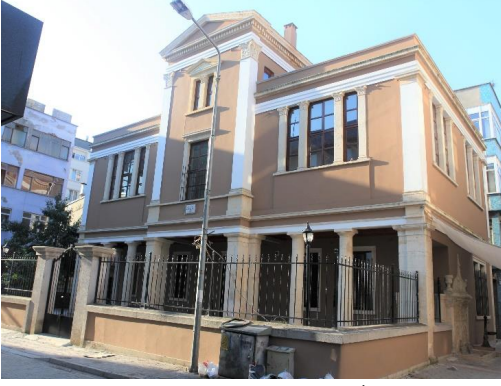
Fot. 21: 1901 tarihli kitabesi bulunan Samsun İbtidai Mektebi ön cephesi
