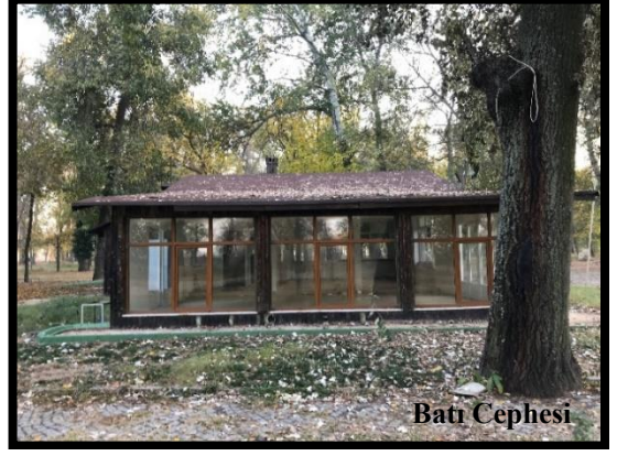
Şekil 4.12 Kafe-restoran yapısının batı cephesi (Orijinal 2022)
