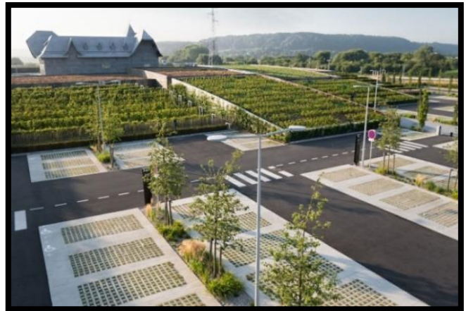
Şekil 4.2 Geçirimsiz asfalt ve yeşil altyapı ile oluşturulan otopark alanı (Anonymous 2014)
