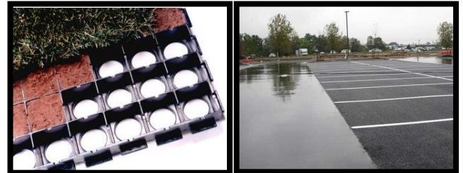
Şekil 4.8 (a) Geoblock malzeme ile otopark uygulaması ve detayı (Karakaya 2016) ve (b) geçirimli asfalt örnekleri (Anonymous 2017)
