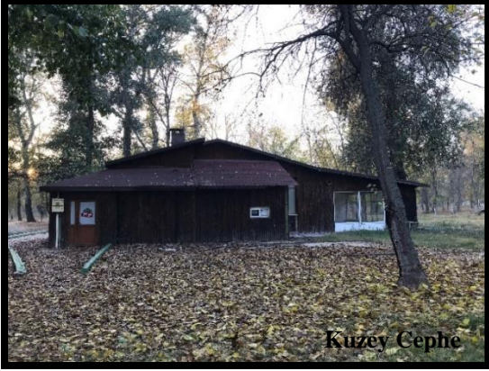
Şekil 4.10 Kafe-restoran yapısının kuzey cephesi (Orijinal 2022)
