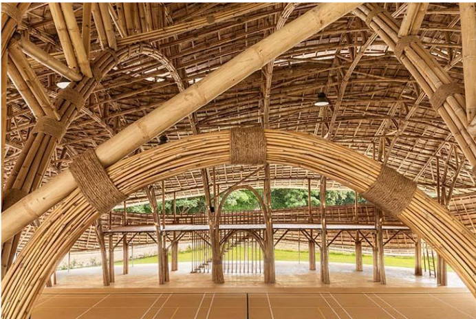
Şekil 6. Bambu Kiriş Sistem Detayı
