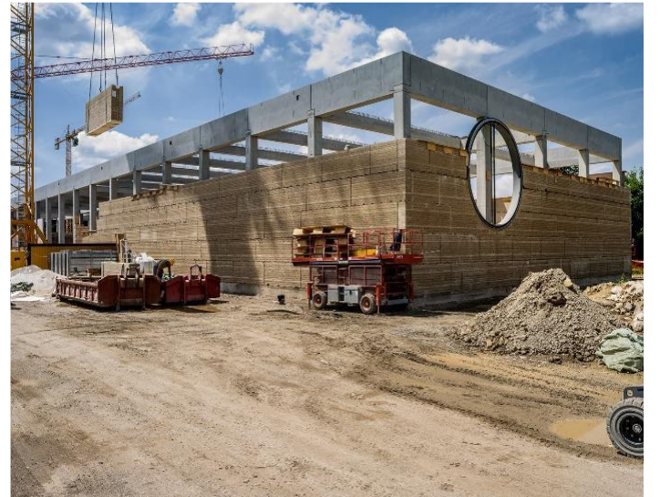
Şekil 11. Ricola Bitki Merkezi Kerpiç Blok Duvar
