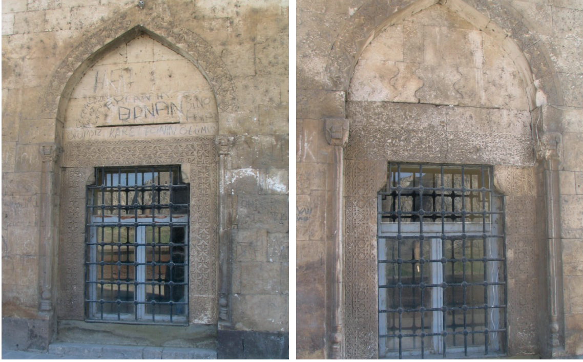
Fotoğraf 26, 27: Kaya Çelebi Camii Kuzey Cephe Pencere Görünüşleri (Kaynak: Ş. Öztürk, 2008)
