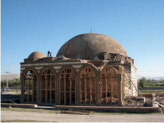
Fotoğraf 51, 52: Kaya Çelebi Camii Deprem Sonrası Görünüşleri (Kaynak: Ş. Öztürk, 2011)
