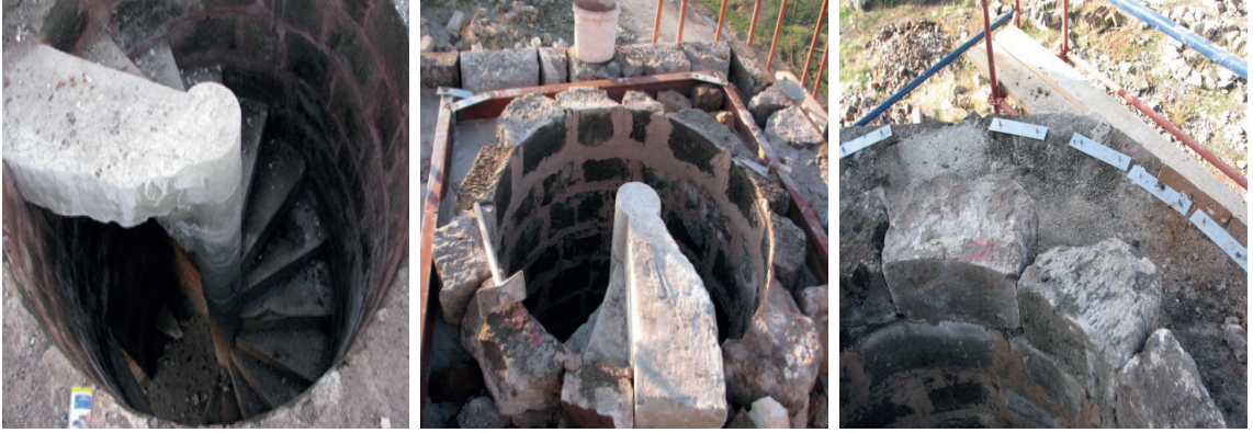
Fotoğraf 73-75: Kaya Çelebi Camii Minare Onarım Görünüşleri (Kaynak: Ş. Öztürk, 2013)
