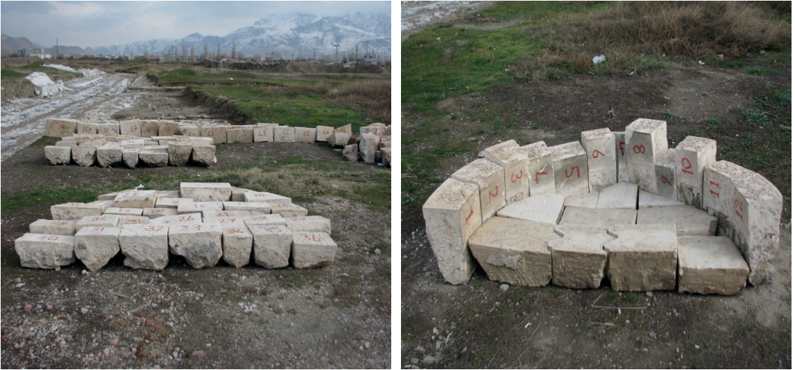
Fotoğraf 76, 77: Kaya Çelebi Camii Pencere ve Beden Duvarı İstif Görünüşleri (Kaynak: Ş. Öztürk, 2012)
