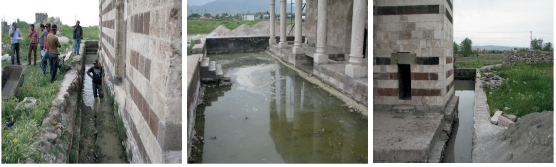
Fotoğraf 93-95: Kaya Çelebi Camii Sondaj Kuyusu ve Drenaj Onarım Görünüşleri (Kaynak: Ş. Öztürk, 2012)
