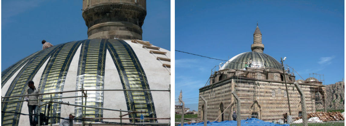
Fotoğraf 88, 89: Kaya Çelebi Camii Kubbe Onarım Görünüşleri (Kaynak: Ş. Öztürk, 2013)
