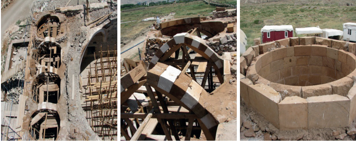
Fotoğraf 78-80: Kaya Çelebi Camii Son Cemaat Bölümü Onarım Görünüşleri (Kaynak: Ş. Öztürk, 2012)
