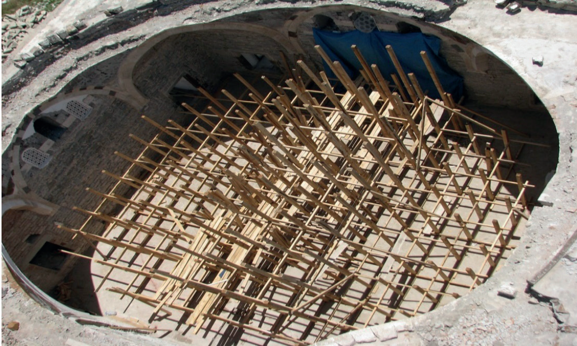
Fotoğraf 81: Kaya Çelebi Camii Kubbe Onarım Görünüşleri (Kaynak: Ş. Öztürk, 2012)
