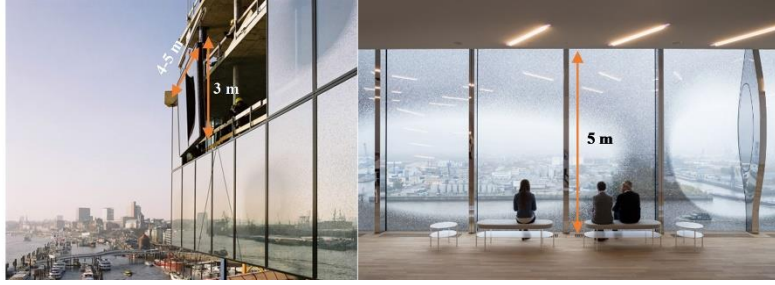
Şekil 21. Cam cephe panelleri ve panellerin montajı [21]
