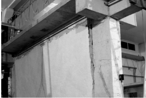
%1.75 - dış duvarın düzlemdışı doğrultuda stabilite kaybı.
