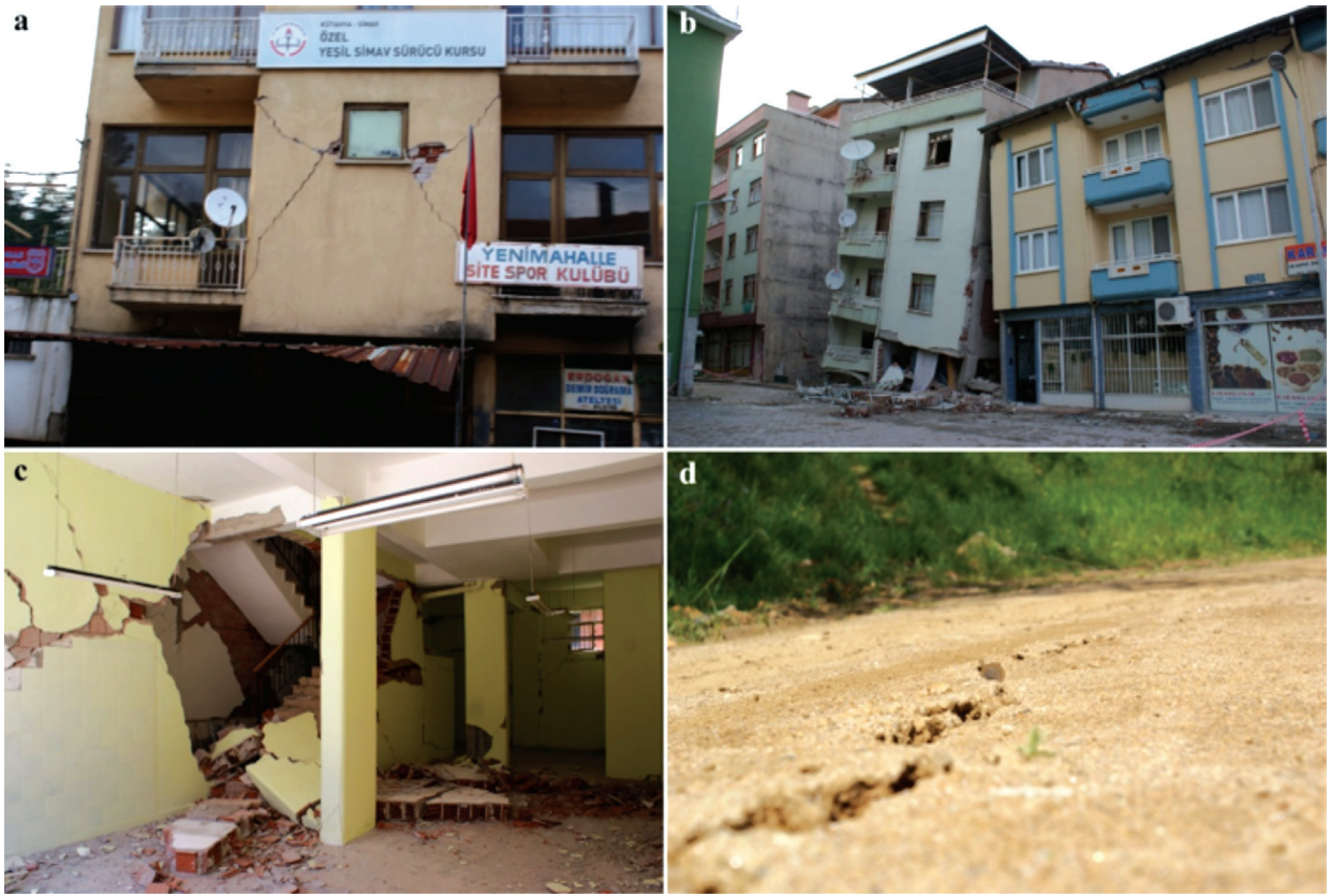
Şekil 5. Simav depremi sonrası meydana gelen yapısal hasarlar (a, b, c) ve yüzey çatlakları (d) Figure 5. Structural damages after Simav earthquake (a, b, c) and surface rupture (d)
