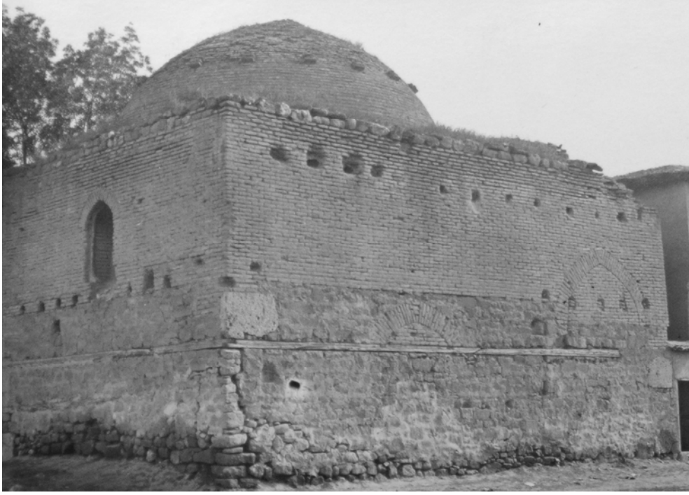
Foto 1: Binanın onarım öncesi güney ve batı cepheleri (V.G.M. Arşivi'nden)
