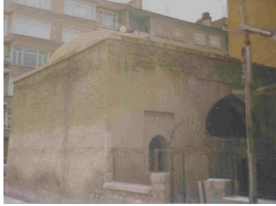
Foto 5: Onarım öncesi doğu (giriş) cephe (V.G.M. Arşivi'nden)
