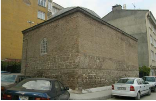
Foto 2: Güney ve batı cephelerin mevcut durumu
