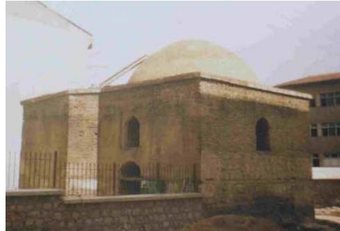
Foto 3: Onarım öncesi batı ve kuzey cepheler (V.G.M. Arşivi'nden)
