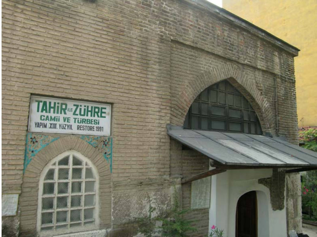
Foto 6: Doğu (giriş) cephenin bugünkü durumu
