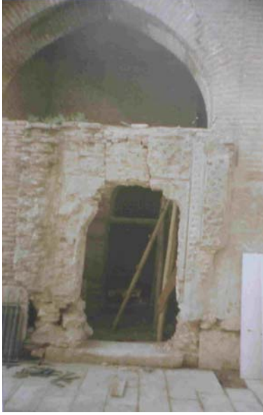
Foto 7: Portalin onarım öncesi durumu (V.G.M. Arşivi'nden)
