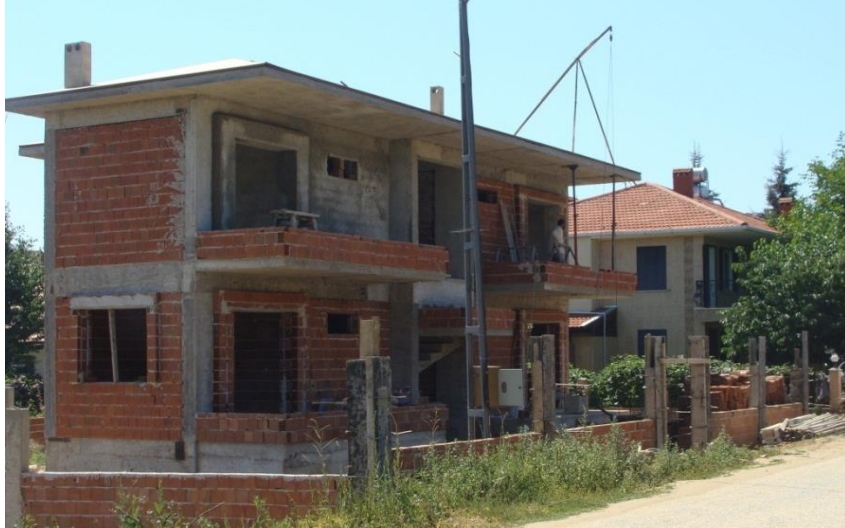
Fotoğraf 6: Gölcük'te Bengisu Caddesi'nde inşa edilen bir bina
