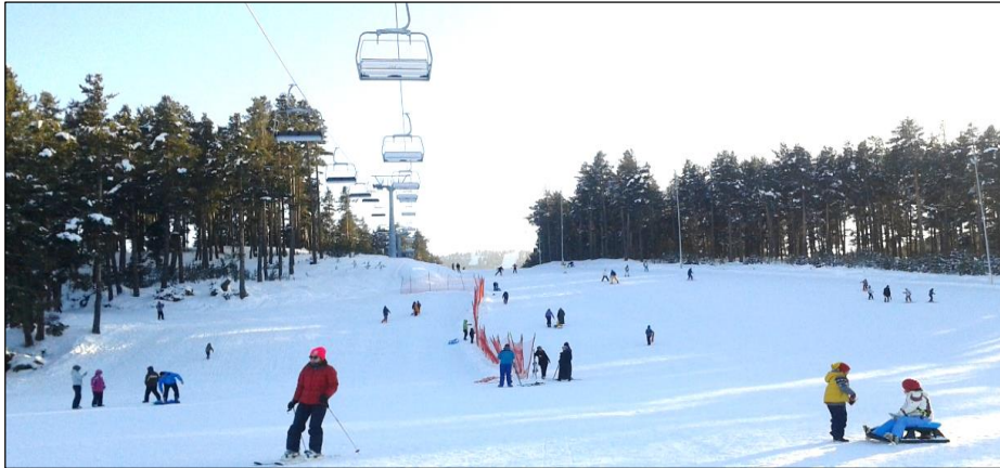
Fotoğraf 6: Bayraktepe kış sporları merkezinde 1. etap 2. lift mekanik tesisleri
