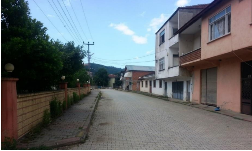
Fotoğraf 5: Ortaköy merkezinde betonarme meskenler (22.06.2014)
