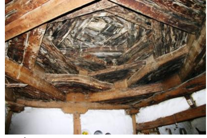
İspir'de Geleneksel Bir Evin Kırlangıç Örtüsü
