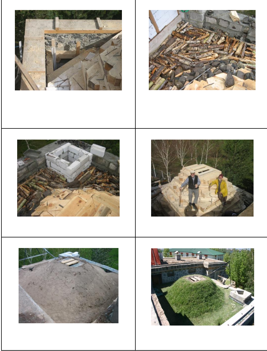
Levha: 4 Atatürk Üniversitesi Geleneksel Erzurum Evi Kırlangıç Örtünün Kuruluş Aşamaları
