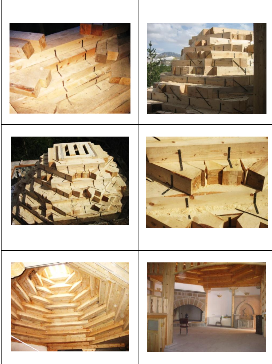
Levha: 3 Atatürk Üniversitesi Geleneksel Erzurum Evi Kırklangıç Örtünün Kuruluş Aşamaları
