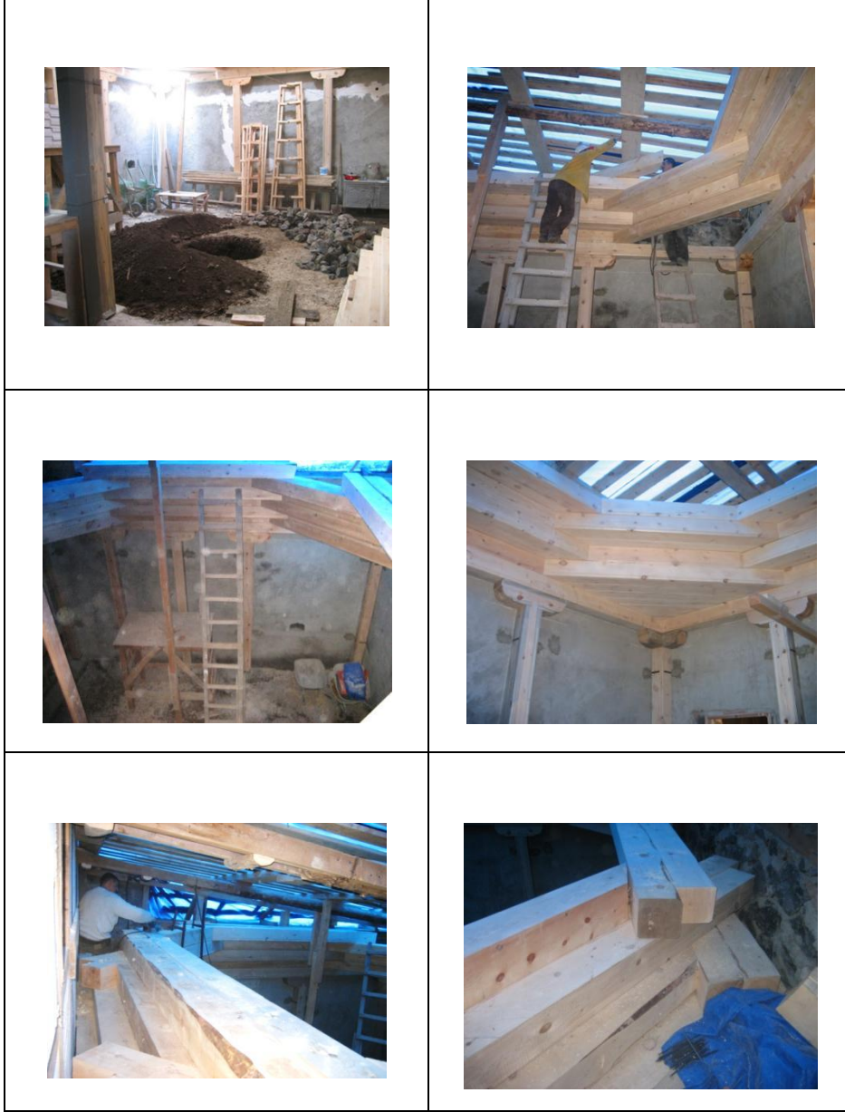
Levha: 2 Atatürk Üniversitesi Geleneksel Erzurum Evi Kırılmaç Örtünün Kuruluş Aşamaları
