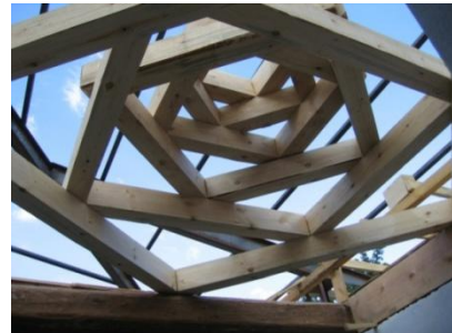
Kare Kırlangıç Örtü Yapımı Erzurum Gümrük Hanı
