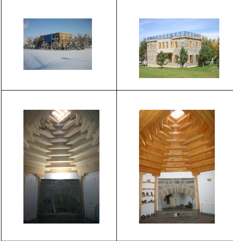
Levha: 5 Atatürk Üniversitesi Geleneksel Erzurum Evi Kırlangıç Örtünün Kuruluş Aşamaları
