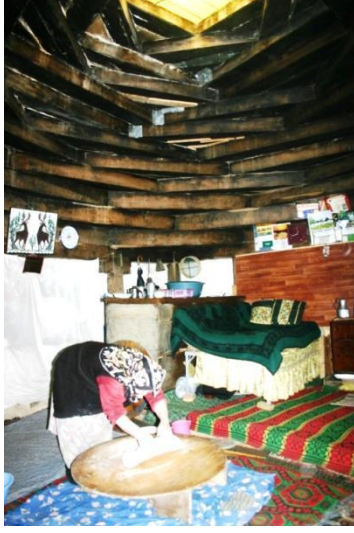
Uzundere' de Geleneksel Bir Evin Kırlangıç Örtüsü
