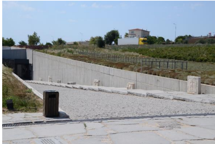
Görsel 2. Müze giriş rampası (sağ duvar)
