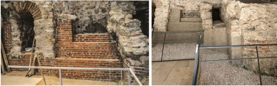
G. 7: Yeni tuğla ile örülen destek duvarları (Soysal, “İbrahim Paşa Sarayı İkinci Avlu Zemin Kotunda Yer Alan Kalıntıların Koruma ve Onarım Çalışmaları”, 113); toprak görünümlü destek duvarları (Neşe Karaçay, 2022).
