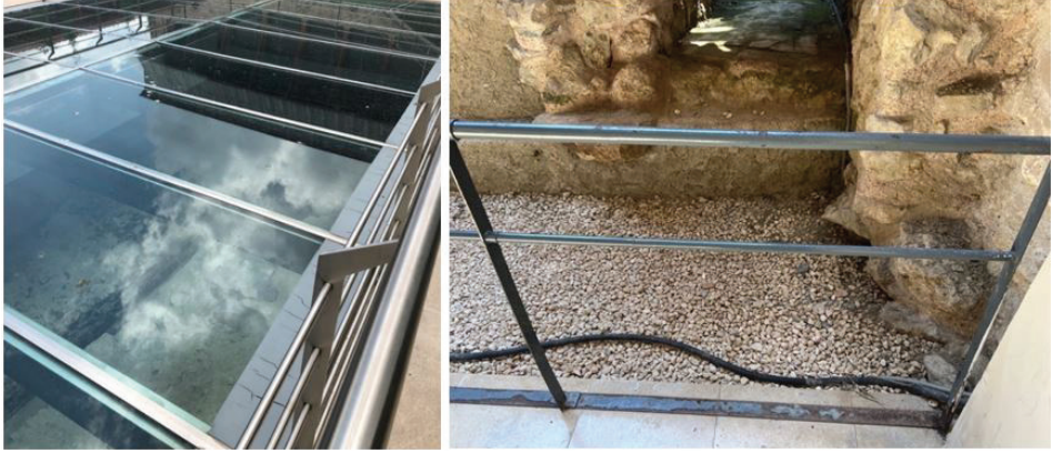
G. 14: Cam döşemede malzeme bozulmaları (Neşe Karaçay, 2018); Kalıntıların bulunduğu döşemelerin çatlaklar ve kırılmalar (Neşe Karaçay, 2022)
