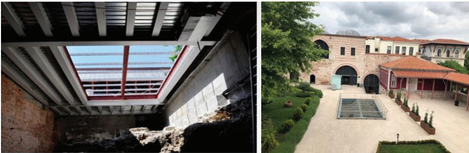
G. 9: Çelik taşıyıcılı cam döşeme uygulaması, Mayıs 2014 (İstanbul IV Numaralı Kültür Varlıklarını Koruma Bölge Kurulu Arşivi); İbrahim Paşa Sarayı'nın 2. avlusundaki görüntüsü (Neşe Karaçay, 2018).
