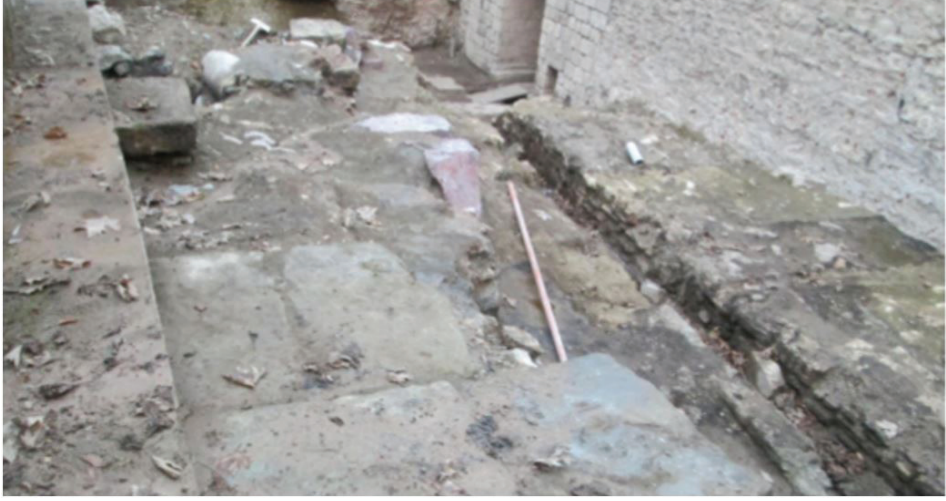
G. 6: İbrahim Paşa Sarayı'nın 2. avlusundaki döşeme (İstanbul IV Numaralı Kültür Varlıklarını Koruma Bölge Kurulu Arşivi- Ekim 2012)
