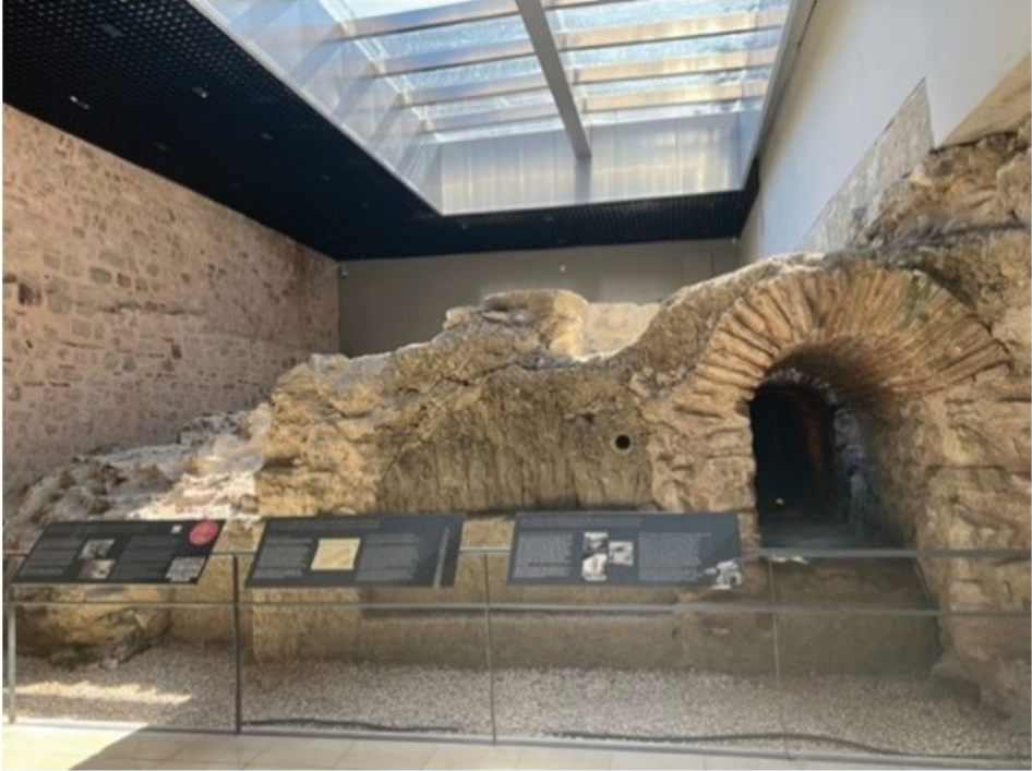
G. 10: Arkeolojik değerlerin korkuluk ve çakıl taşlı alan ile ziyaretçi gezi alanı döşemesi, cam üst örtü ve asma tavan (Neşe Karaçay, 2022).
