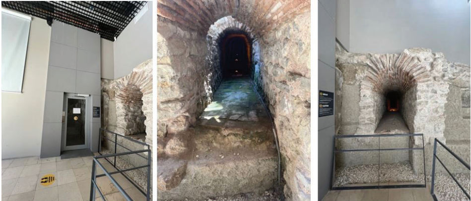
G. 13: Kalıntılarda oluşan nem ve rutubet sorunları ile uygulama sonrası zeminde oluşan çatlaklar (Neşe Karaçay, 2022).
