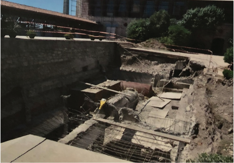
G. 2: İbrahim Paşa Sarayı 2. avlusundaki kazı alanı güneybatı yönü-1983 yılında gömülen ısıtma sistemleri (İstanbul IV Numaralı Kültür Varlıklarını Koruma Bölge Kurulu Arşivi-Ekim 2012).
