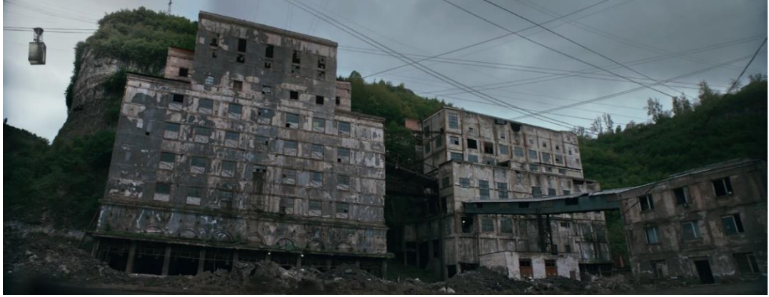
Görsel 1. Maden Sahasında Ana Binanın Genel Görünümü
