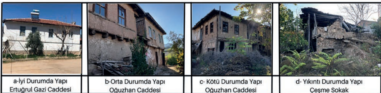
Levha 5. Yapısal durumlarına göre yapı örnekleri / Examples of buildings by their structural stability (Öztürk, 2022).
