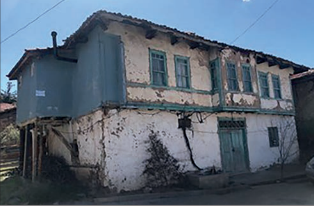
Fotoğraf 4. Semerci Hasan Evi sokak cephesi / Semerci Hasan House street facade (Öztürk, 2022).
