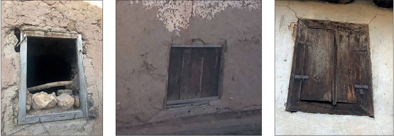
Fotoğraf 3, 3a, 3b. Zemin kat pencere açıklıkları / Ground floor window opening (Öztürk, 2023).
